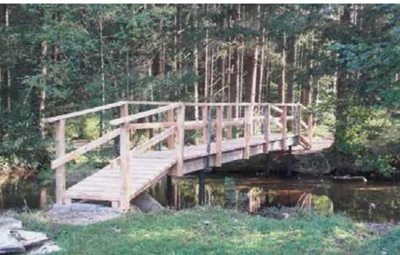
Wiedererrichtung Brücke im Kreuzerbauernmoos
