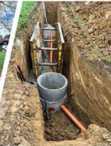
Wasser und Kanal Außerreith
